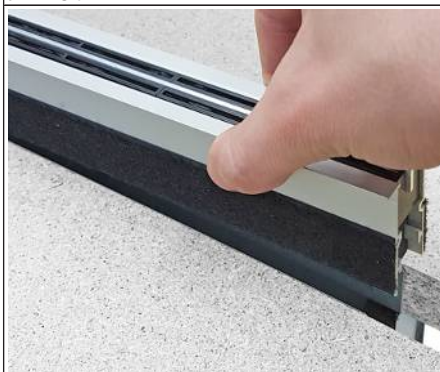
Rys. 11: Wsuwanie wylotu szczelinowego
