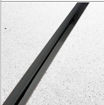
Rys. 10: Skrzynka przyłączeniowa zlicowana z podłogą
