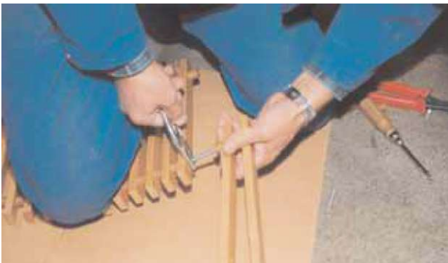
Krok 6: Skrócić pozostałe sprężyny kratki
