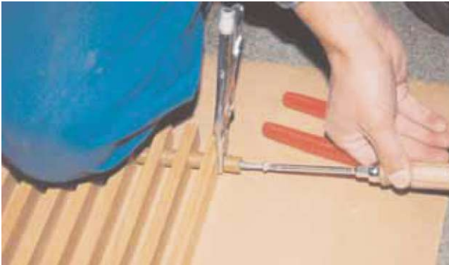
Krok 5: Przykręcić sprężynę
