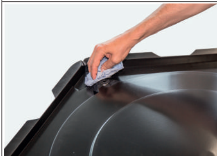
Rys. 35: Czyszczenie wanny kondensatu
