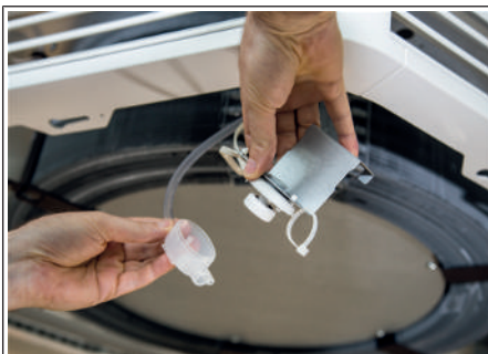
Rys. 37: Zdejmowanie pokryw
