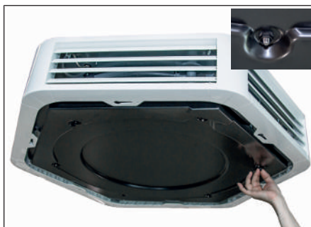
Rys. 33: Odkręcanie nakrętki wtykanej z wanny kondensatu
