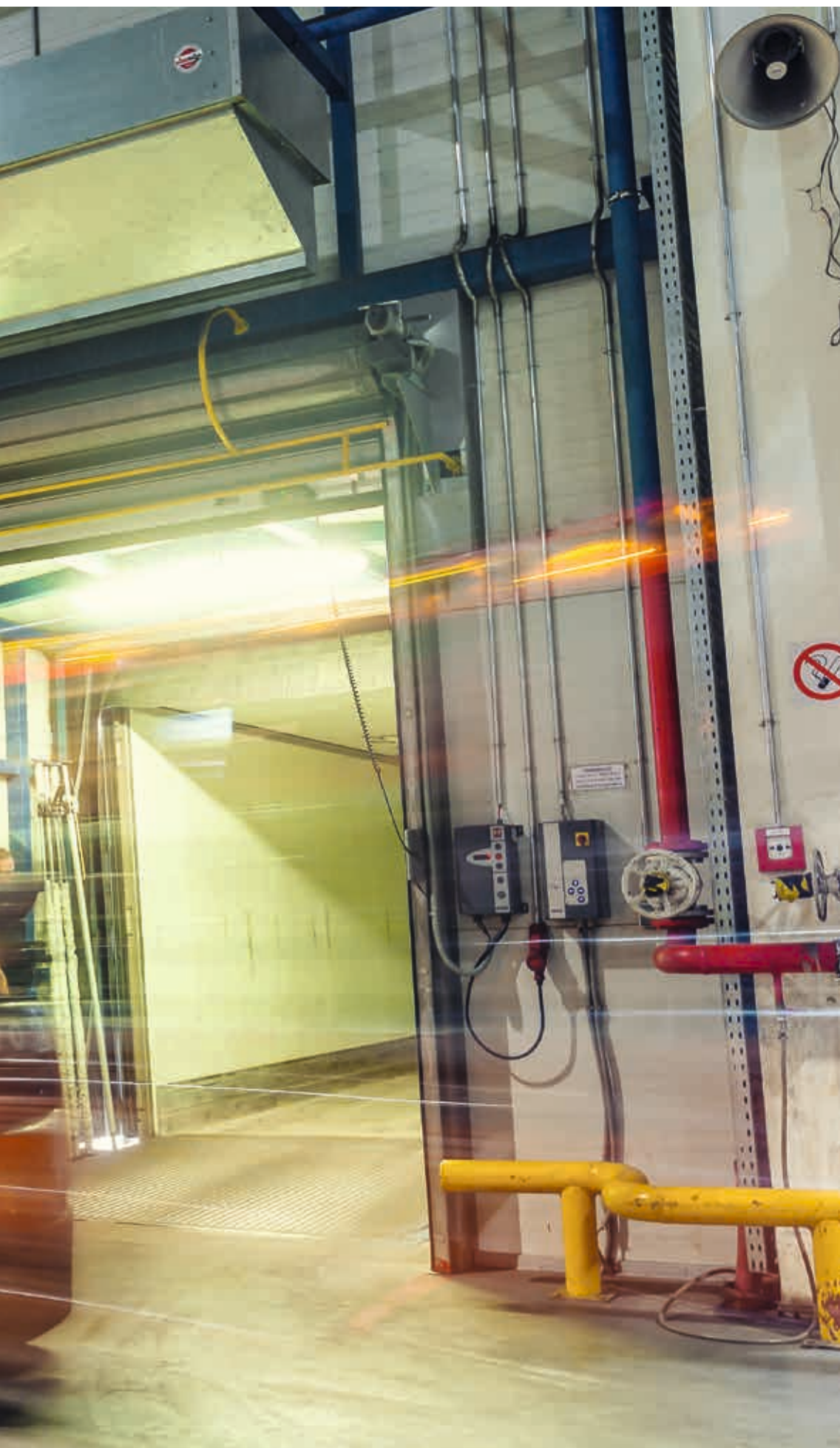
Kurtyny powietrzne ProtecTor zapobiegają wlotowi zimnego powietrza w obszarze załadunku w oddziale Heineken „Wolga”, Nizhniy Novgorod, w sercu Rosji.
