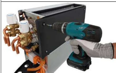
Rys. 71: Demontaż głównej wanny kondensatu (wersja ścienna)
