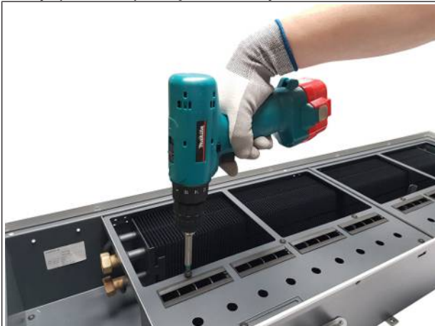
Rys. 8: Odkręcenie śrub w osłonie
