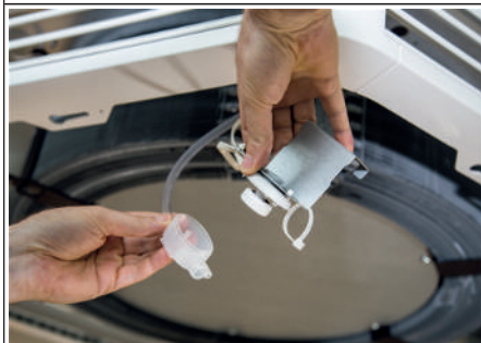
Rys. 17: Zdejmowanie pokrywy
